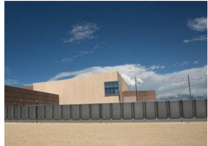
Instalación de Ebay de 6 MW de pila de combustible
